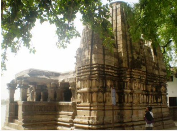
Sijahari, distretto di Mahoba, tempio delle Chausat Yogini, ricorso alternato di lastre pentagonali e romboidali lungo tutte le proiezioni
