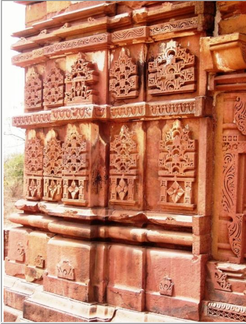
Tempio Chandella in Chandpur con udgamas pentagonali in ogni proiezione o ratha del muro del jangha
