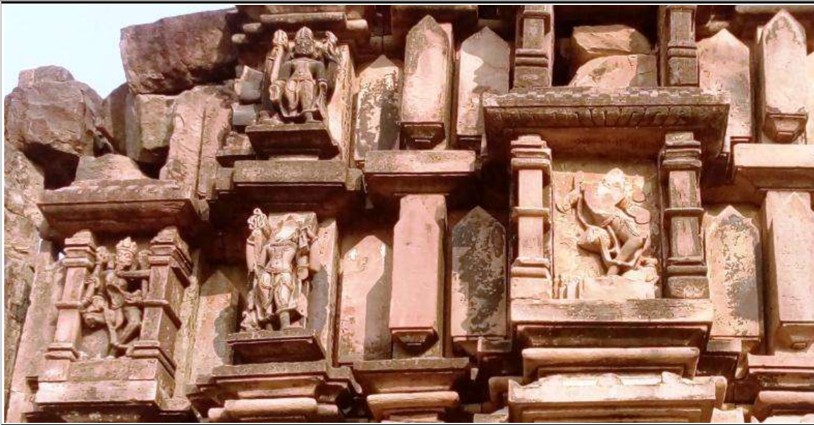
Parete del jangha occidentale del Tempio minore di Gonda
