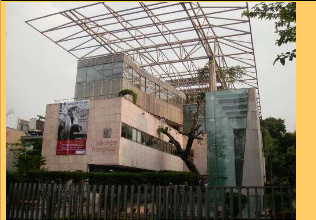
L'edificio dell' Alliance française , 2004 SPA DESIGN & ABRD Architects
