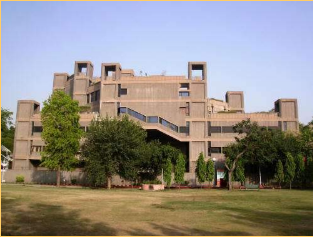
Il National Science Centre, un'opera di Kanvinde del 1992
