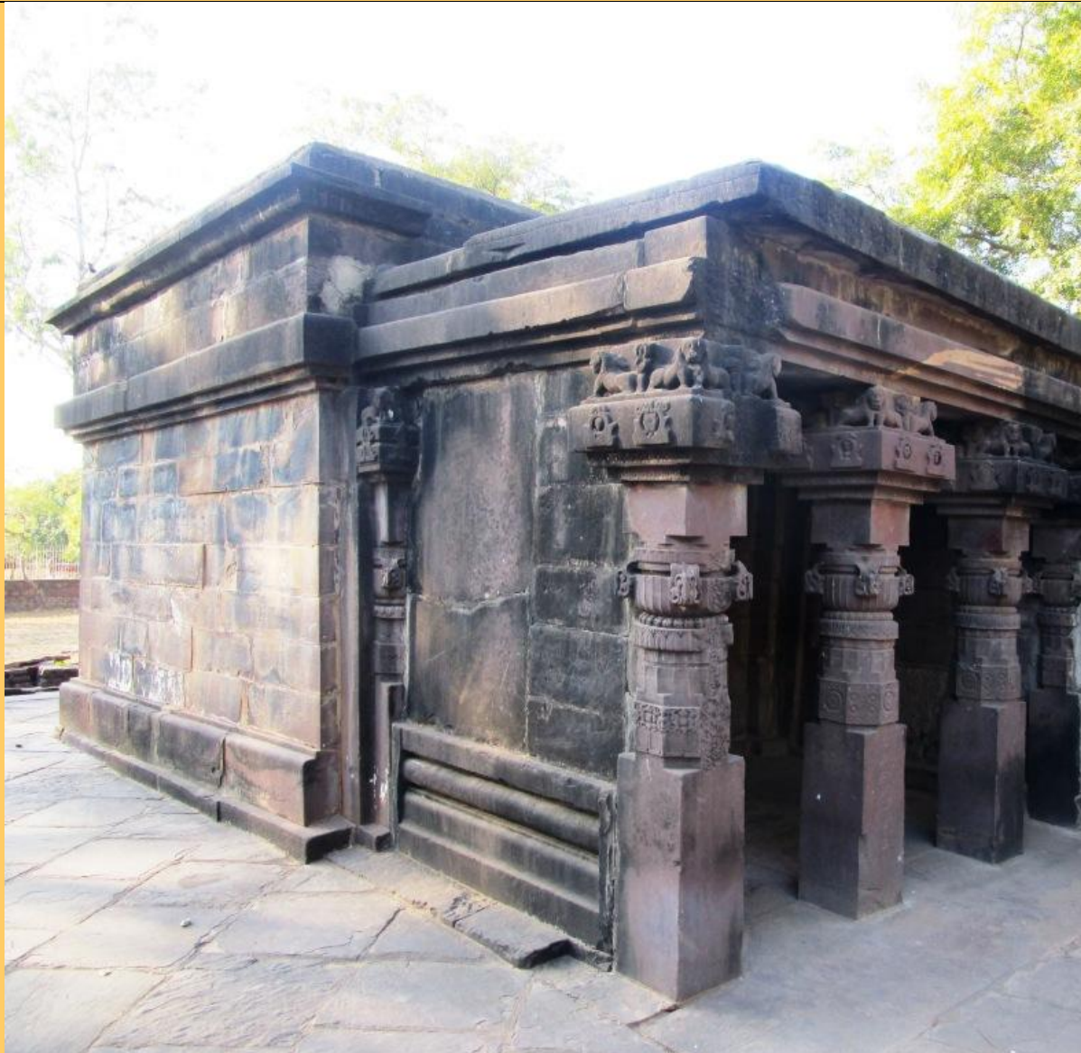
Modanature rettilinee o curve le profilature quadruplici del basamento del portichetto, e quelle duplici del santuario.
